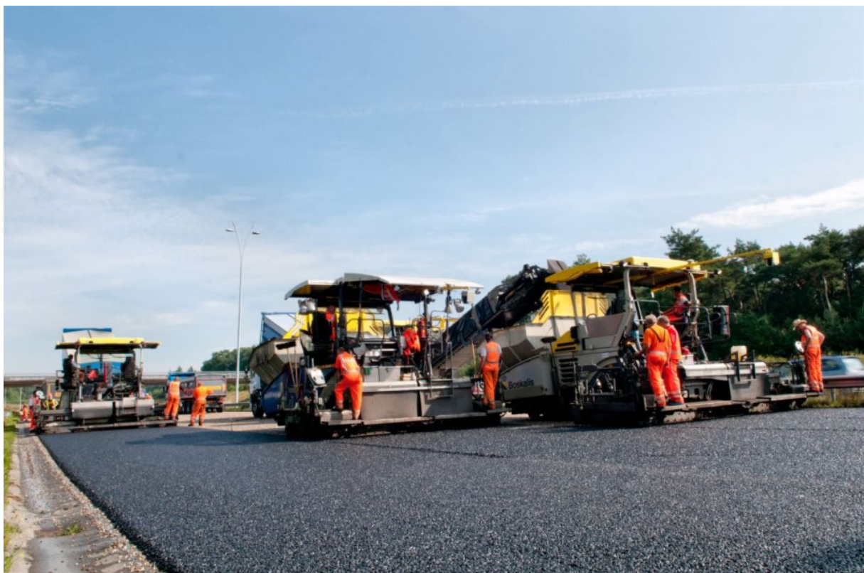
Figuur 9. De asfaltsets van 2,5 tot 6,5 meter van Boskalis.
