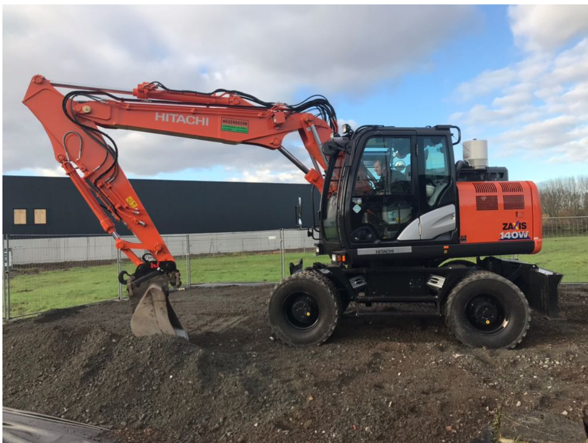
Figuur 6. Hierboven is een mobiele kraan afgebeeld. Een dergelijke kraan is ingezet tijdens dit project. Boskalis heeft de kraan gehuurd van Heijting.
