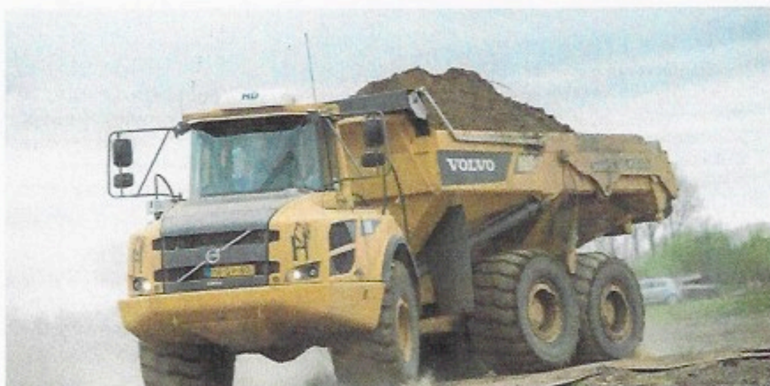
Figuur 3. Hierboven is een van de dumpers te zien die De Haan (een onderaannemer van de NIP, de uitvoerder van het project N345) heeft ingezet voor de grondwerken. Een dumper kan effectief grote hoeveelheden zand verplaatsen.
