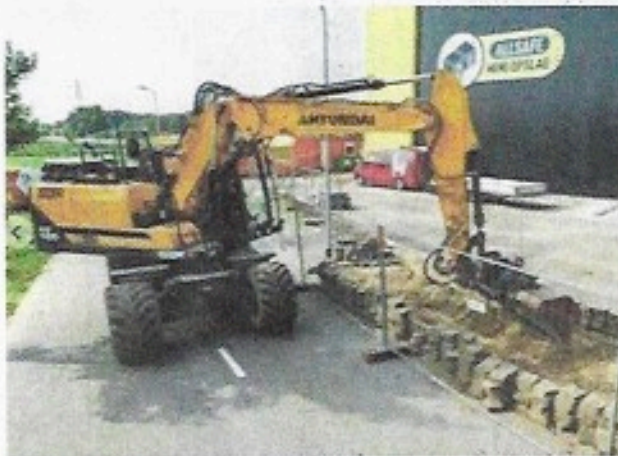
Figuur 8. Hierboven is een mobiele kraan te zien van Van Reel (onderaannemer). Van Reel heeft De Haan ondersteund bij het uitvoeren van de grondwerken op de projectlocatie.
