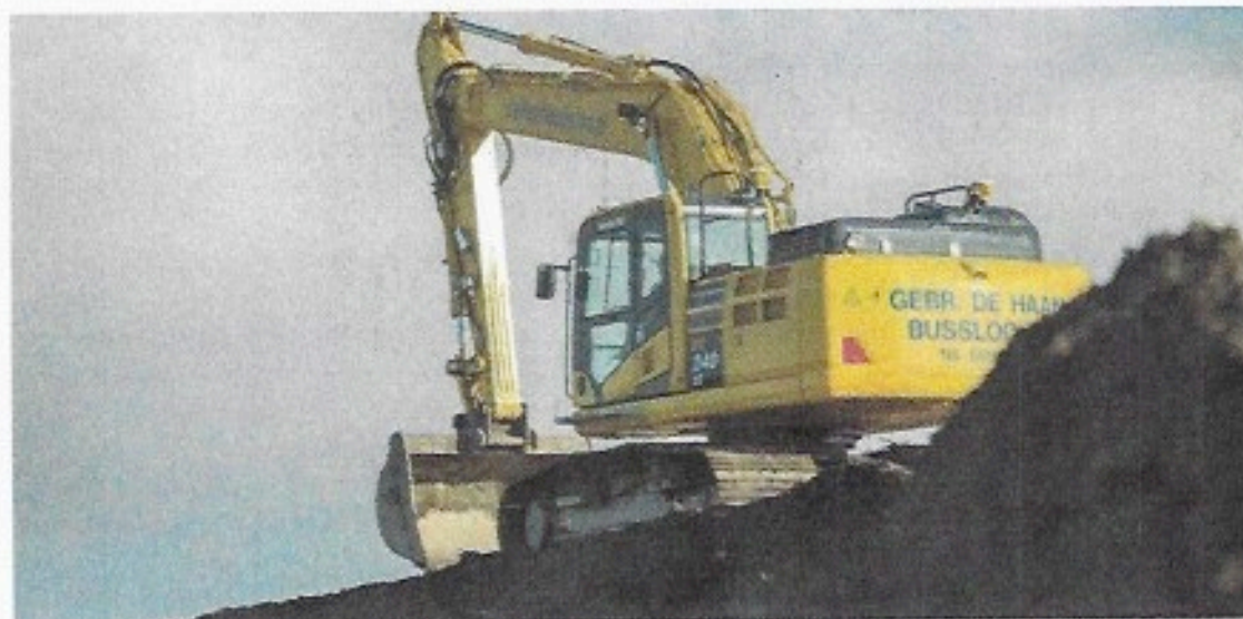
Figuur 4. Hierboven is een kraan te zien van De Haan. Met een kraan heeft dit bedrijf tijdens de grondwerken grond kunnen opgraven en op korte afstand kunnen verplaatsen.
