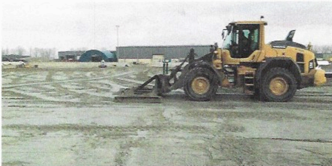
Figuur 5. Hierboven is een shovel te zien van De Haan. Met een shovel heeft dit bedrijf tijdens de grondwerken grote hoeveelheden grond verplaatst en de dumpers gevuld met grond.
