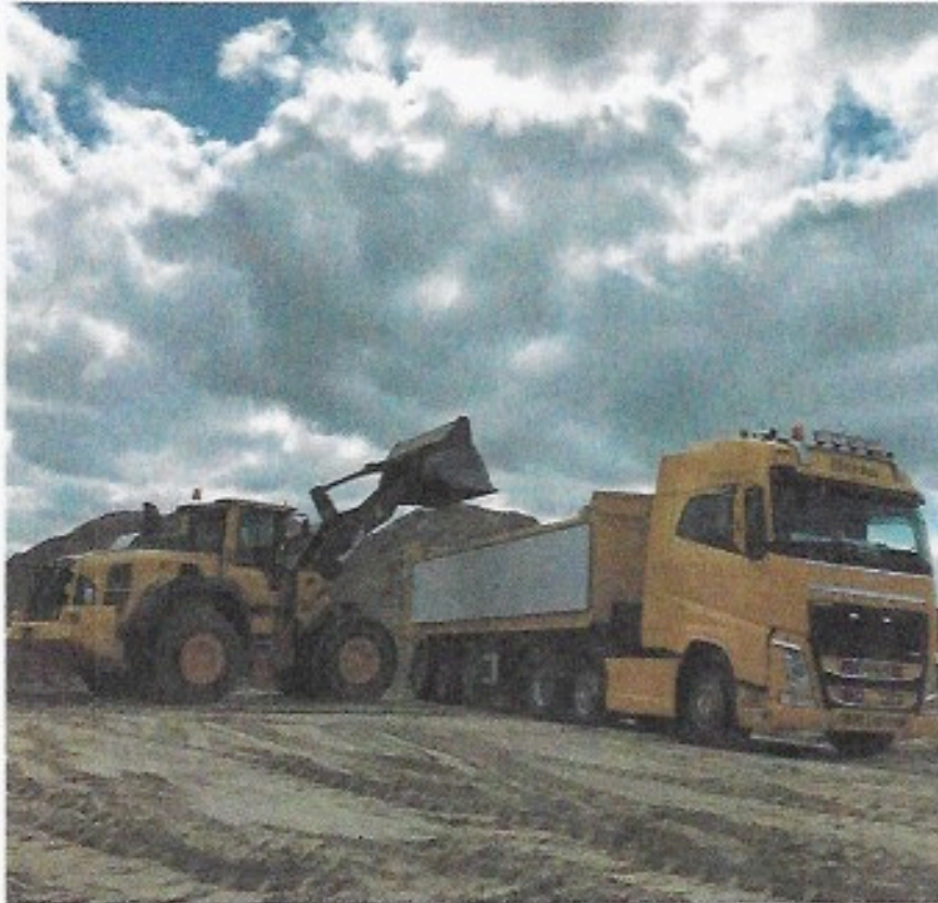
Figuur 7. Hierboven zijn een shovel (links) en een Kipper trailer (rechts) te zien van het bedrijf Derks. Met een shovel zijn de kipper trailers gevuld met zand van de zandput. De Kipper trailers vervoeren het zand naar de projectlocatie en rijden vervolgens weer leeg terug.
