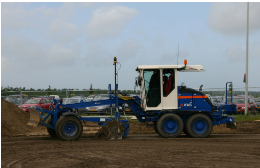
Figuur 8. Hierboven is een grader te zien gebruikt door KWS. Deze is ingezet voor het egaliseren van de ondergrond.
