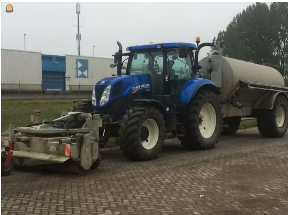
Figuur 7. Hierboven is een trekker-waterwagencombinatie te zien gebruikt door KWS. Deze is ingezet om de aangebrachte fundering schoon te sproeien. Dit voorkomt stofwolkvorming.
