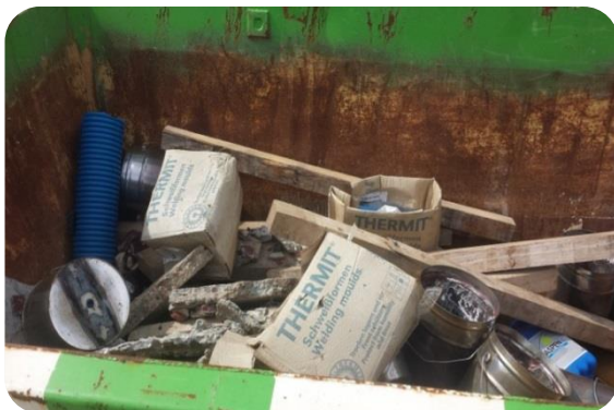
Figuur 5-2 Slecht gesorteerd bouw en sloopafval (BSA)
