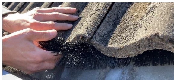
Figuur 4 Toepassing gootborstel of weringsborstel
