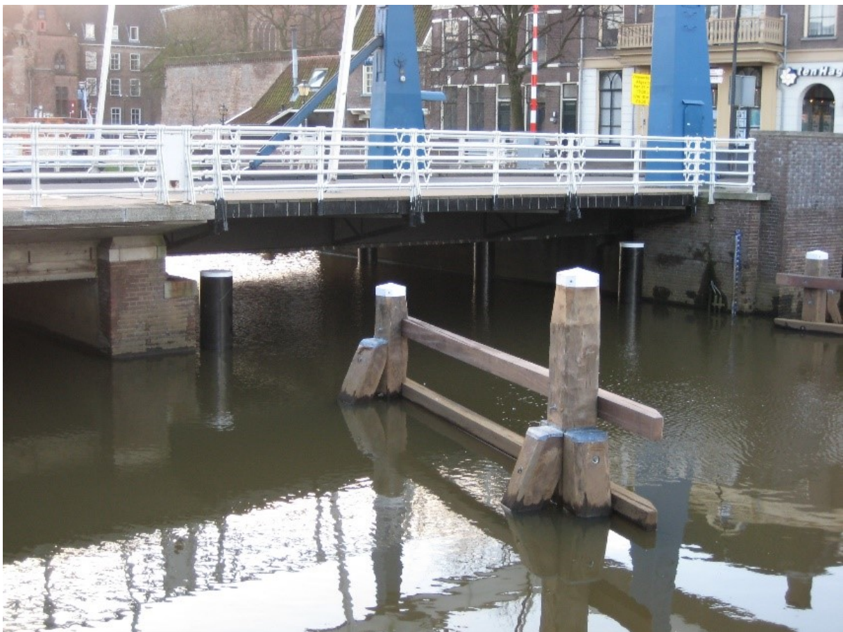
figuur 2-19: Remmingwerk waarbij gebruikte basra-locus palen zijn toegepast, Zwolle
