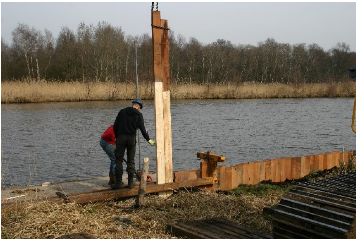
figuur 2-2: Gevingerlaste combi-damwandplanken hardhout - naaldhout
