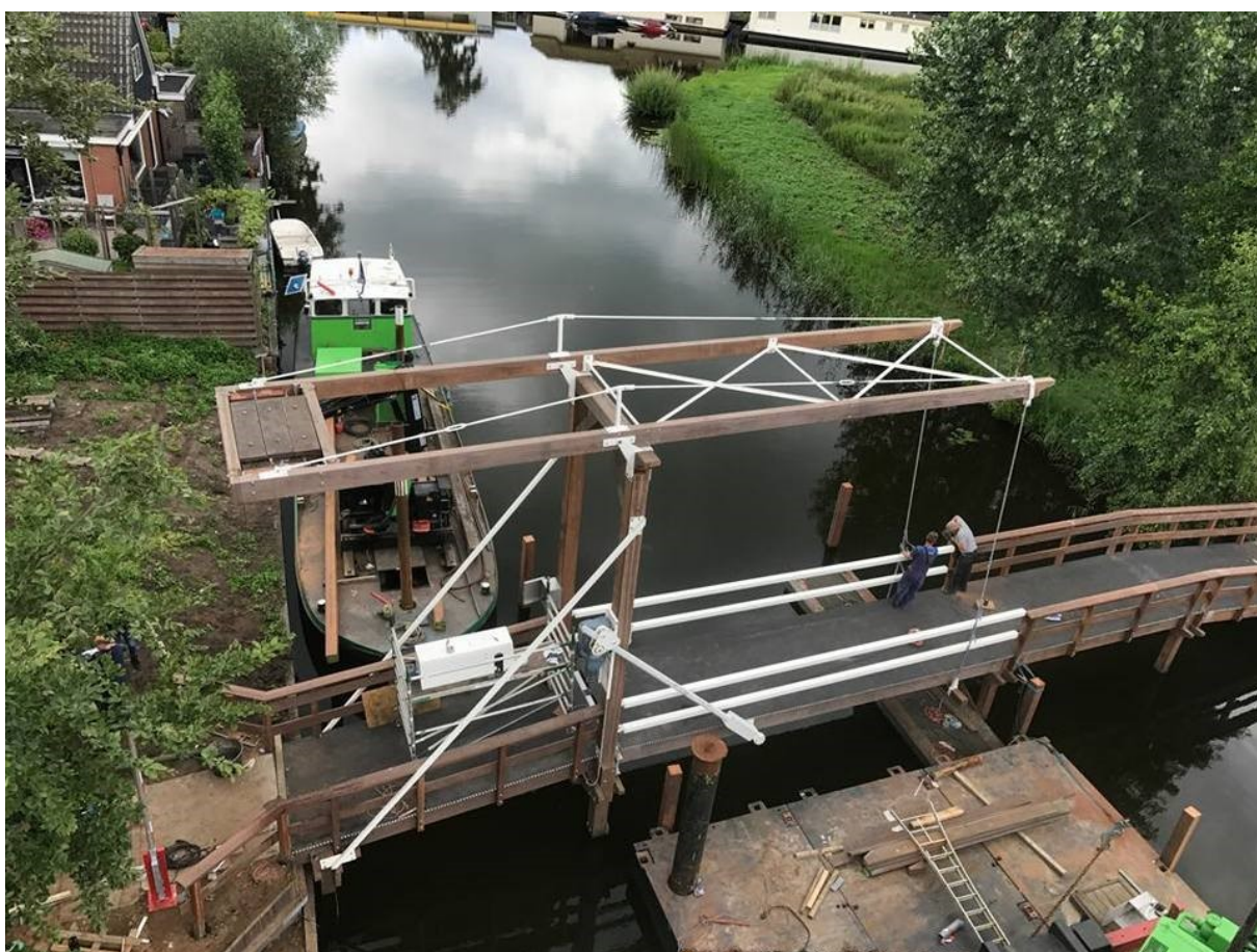
figuur 2-1: Realisatie van een houten ophaalbrug
