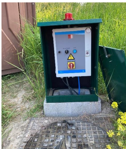
Foto drukriool (links: oppervlakte met open regelkast, rechts in de pompput)
