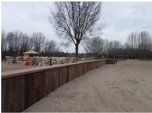
Figuur 3-3: hardhouten beschoeiing
