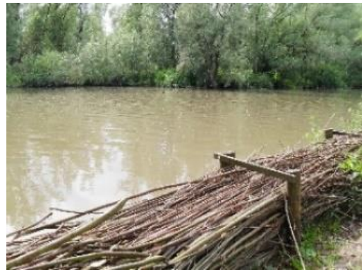
Figuur 3-6: beschoeiing bestaande uit rijshout
