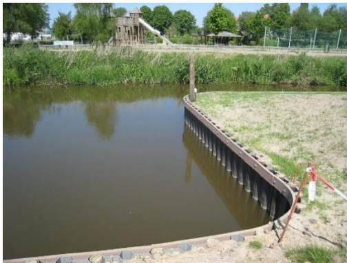
Figuur 3-5: kunststof beschoeiing
